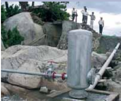
Wasserversorgung mit einem Hydraulischen Widder in Vietnam
